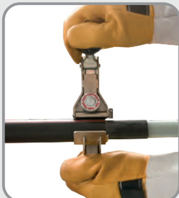
Pentru efectuarea creștăturilor pe mantaua cablurilor cu ecran din bandă de AL
